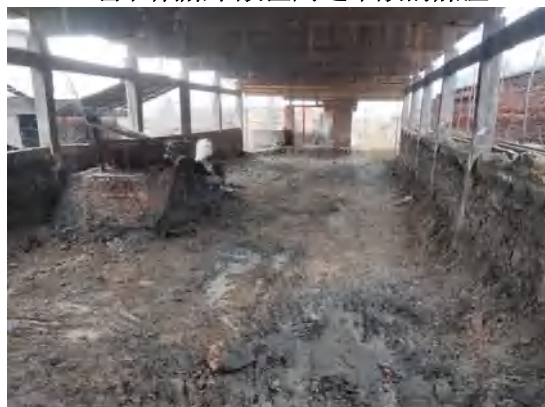
原石煤堆放区现状
