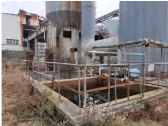
废气治理区水池
